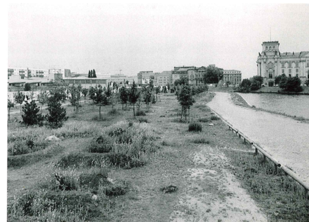
Kapelle-Ufer im Bereich des Reichstagsgebäudes
